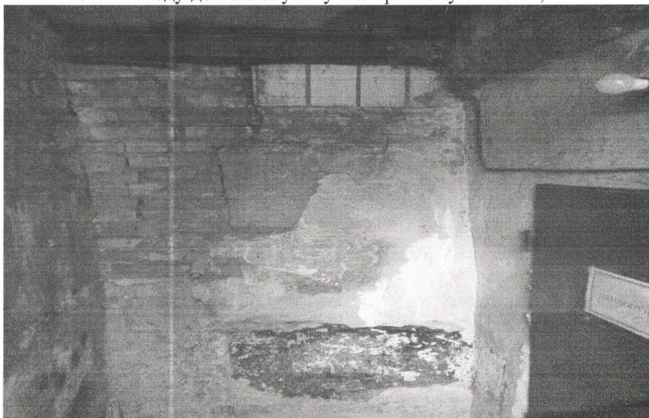
Стіни входу до теплопункту в аварійному стані - 7,2 м 2
