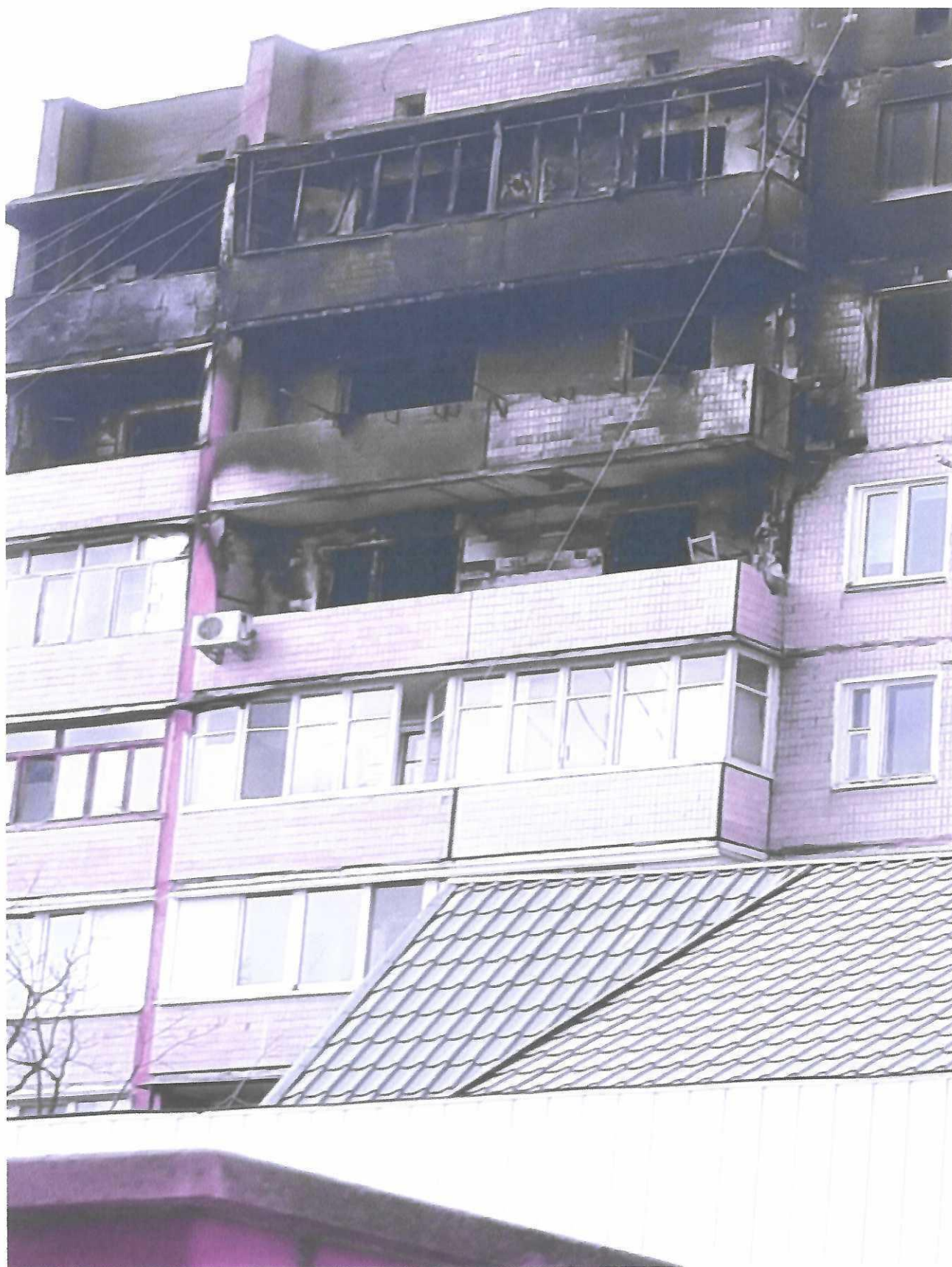
Рис. 3.1. Руйнування фасаду будинку 61 на 7-9 поверхах після вибухів та пожежі
