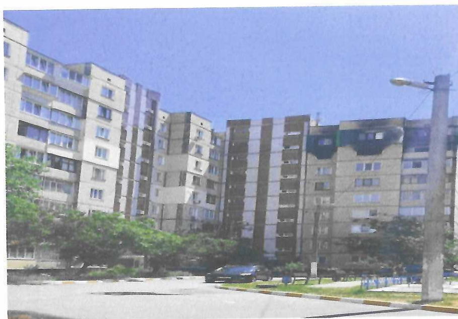
Рис.2.2. Фасад будинку 61, підїзд 3
